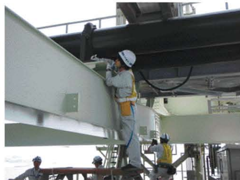
● 送水管の定期的点検
