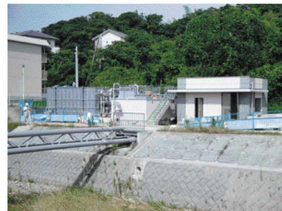
● 浄水場の更新工事
