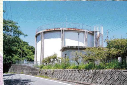
●小山田配水池
