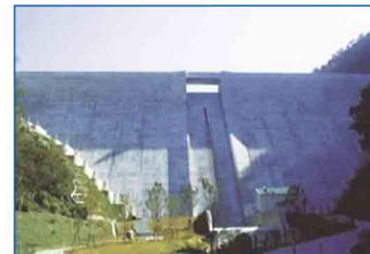
取水施設 ダムから水を取ります。
