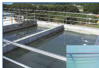
フロック形成池 水の中の小さなゴミを薬の働きで沈みやすいかたまりにします。
