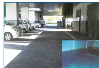
浄水池 きれいになった水を溜めておき各家庭に送ります。 (地下に1,000mのタンクが2つあります。)
