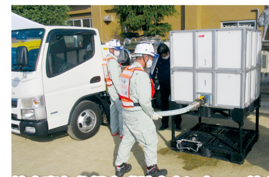
給水車から組立式貯水タンクへの給水
