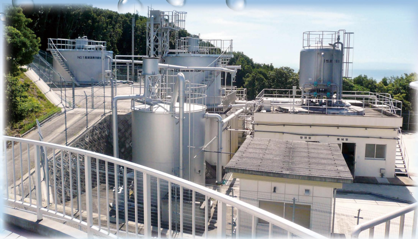
楠本浄水場(淡路市楠本)
