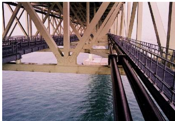
明石海峡大橋添架送水管
